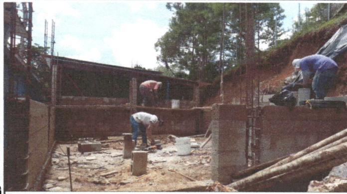
Foto1: Continuidad en la remodelación de paredes en todas las áreas del espacio priorizado para cocina, colocacion de parales y fundicion.
