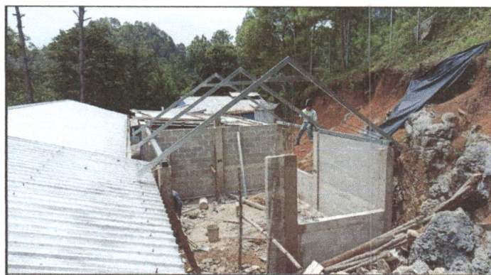
Foto 4: Instalacion de costaneras, tendido electrico, y laminas troqueladas en el techo correspondiente a la cocina.
