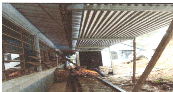
Foto 6: Instalación de tendido electrico en areas correspondiente al corredor, e instalacion de laminas.
