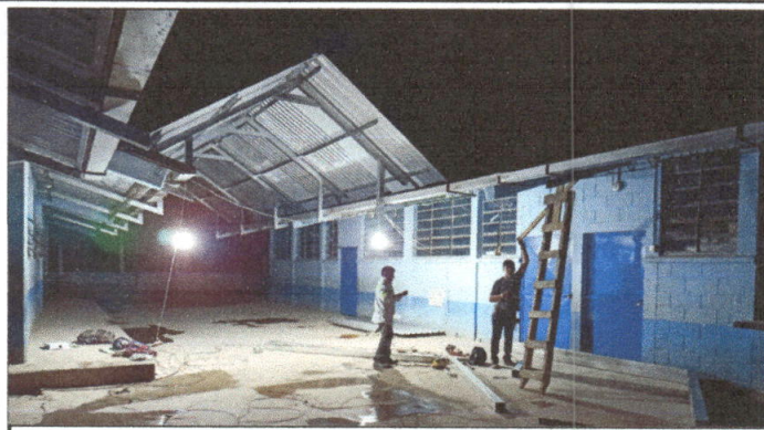
Foto 2: Instalación de laminas troqueladas y tendido electrico en área correspondiente al escenario como parte del cambio de techo.
